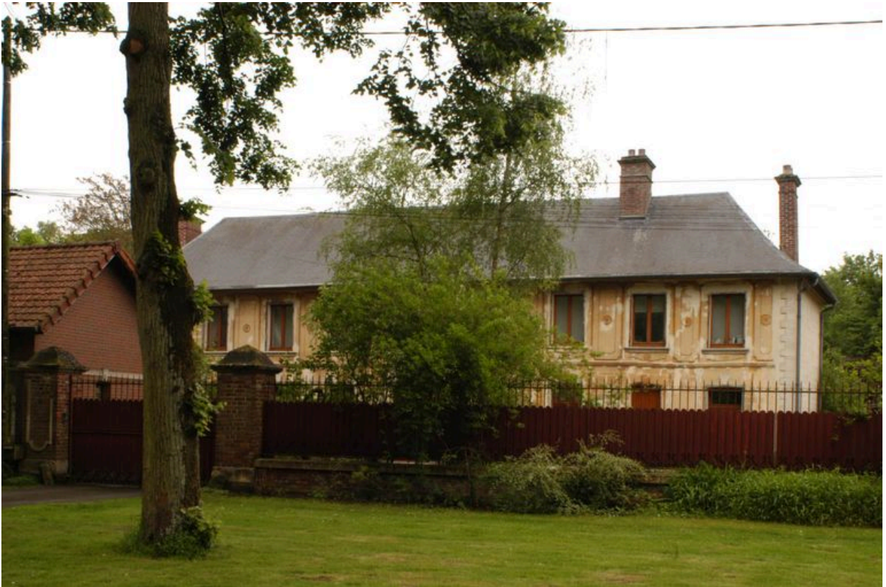
Vue générale depuis l'est.
