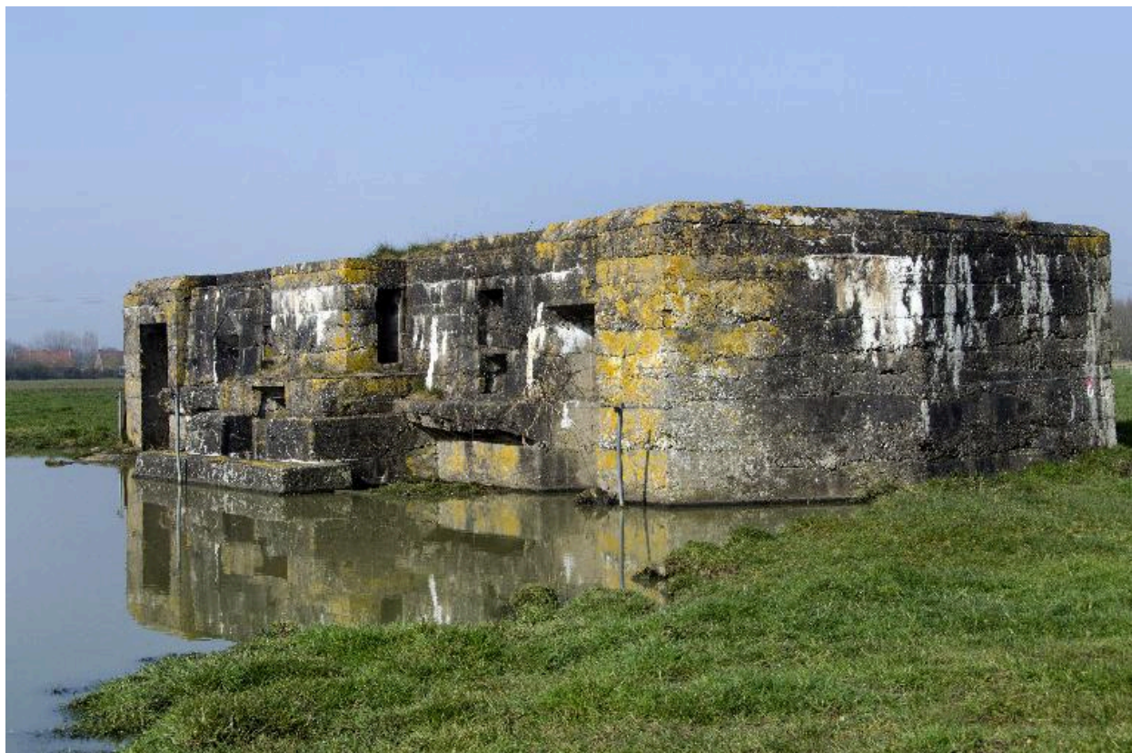
Vue de trois-quarts vers le nord-ouest
