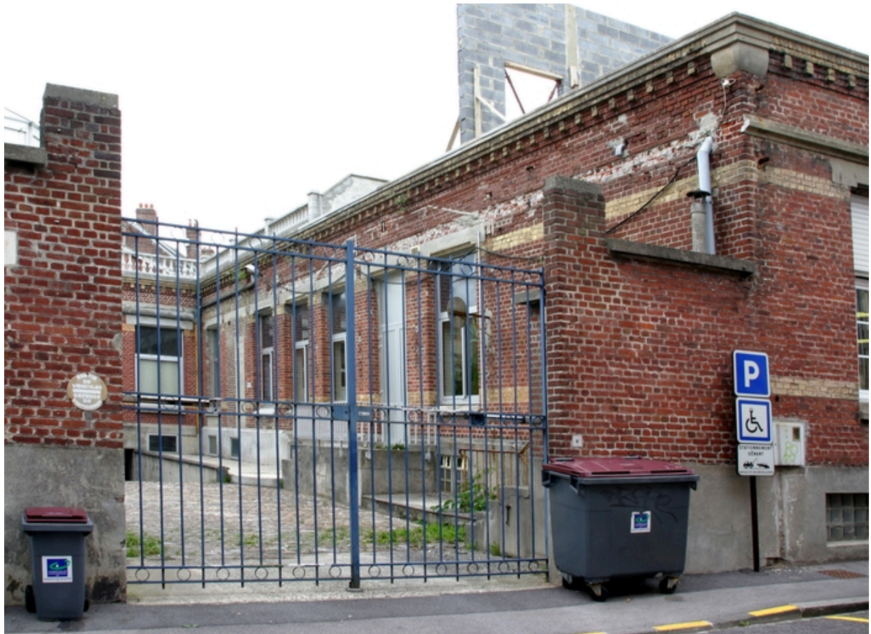
L'entrée et la façade sur cour de l'usine.
