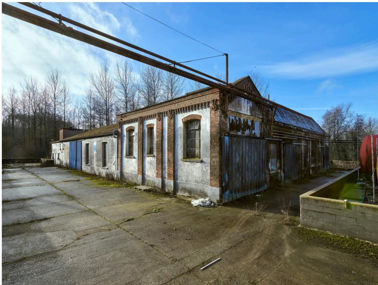
Vue générale nord-est d'un atelier (bâtiment M).
