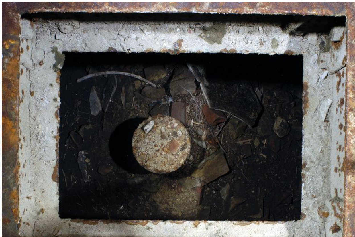
La turbine hydraulique, vue de dessus.
