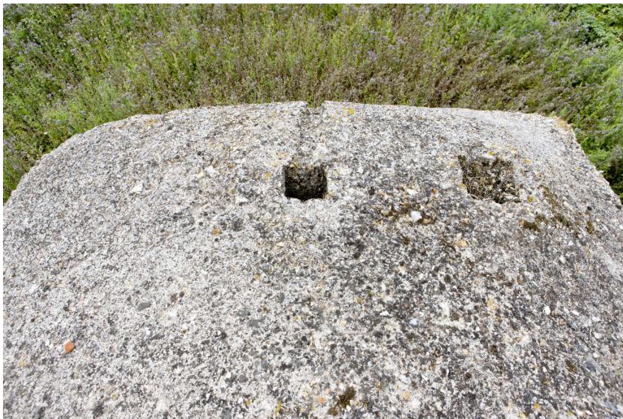
Partie sud-ouest du couvrement avec aération et/ou cheminée périscopique
