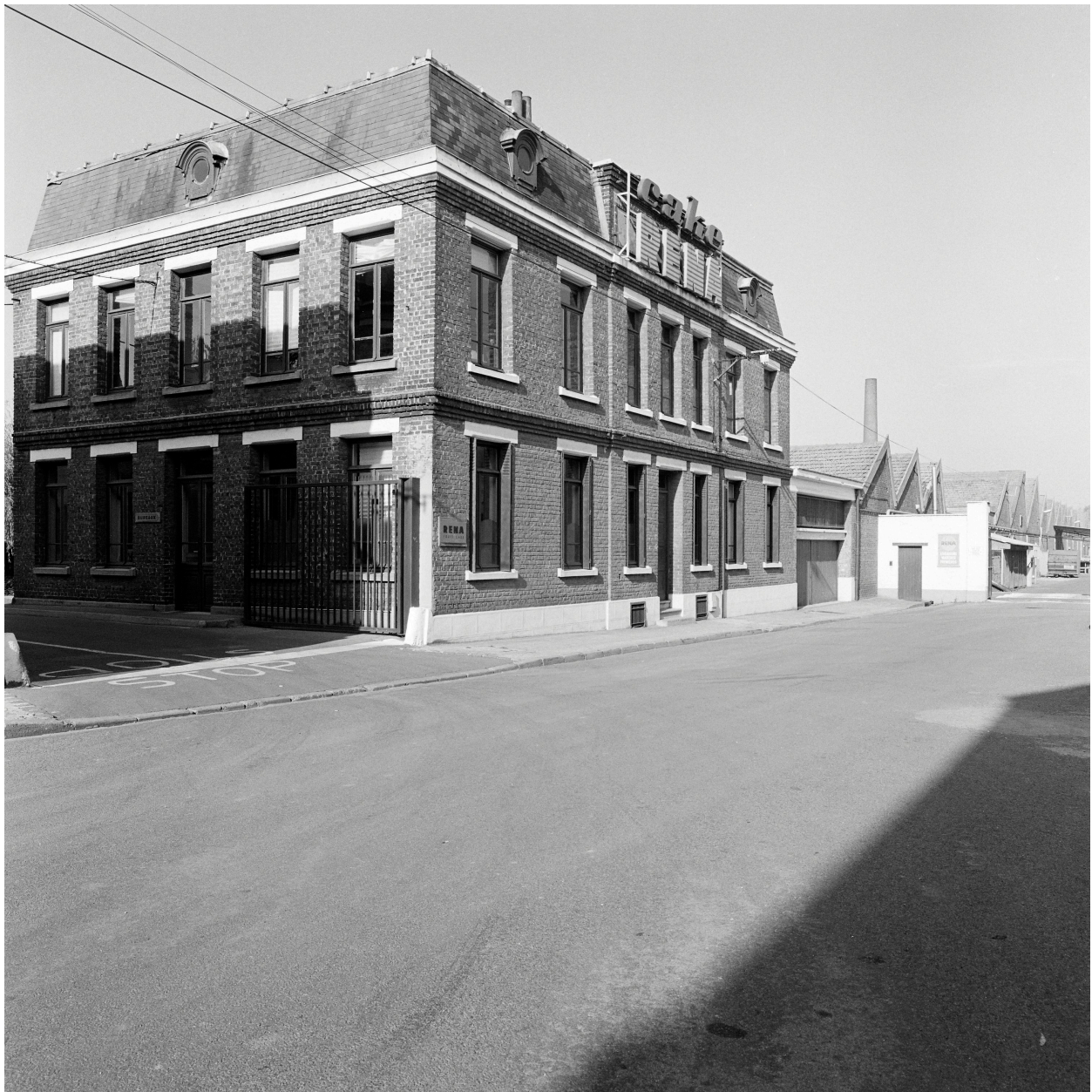
Bureaux et atelier de fabrication. Vue prise vers le nord.
