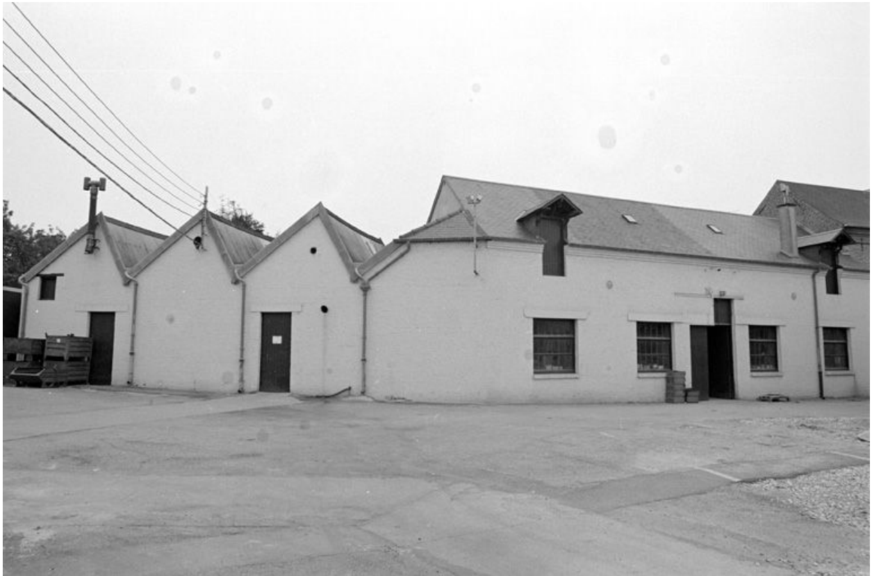
Atelier de fabrication, vue partielle, flanc est, en 1990.
