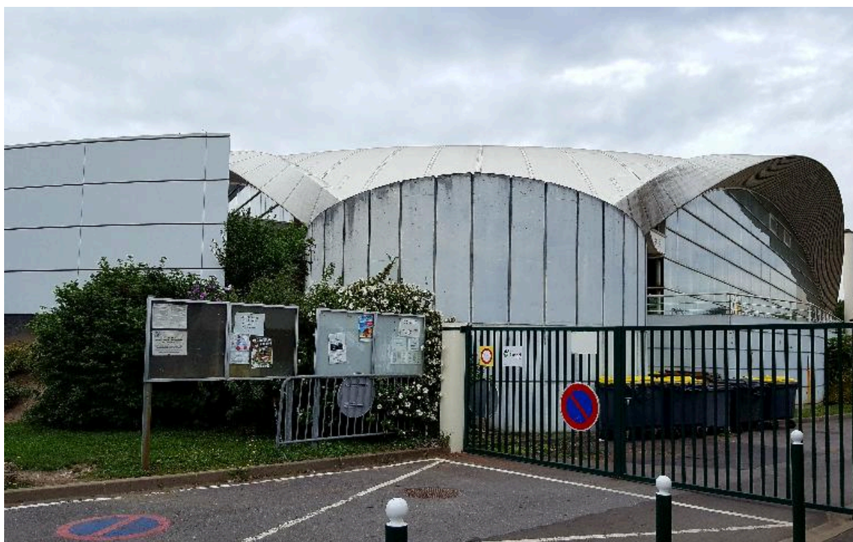
Vue d'une culée et de la façade est.
