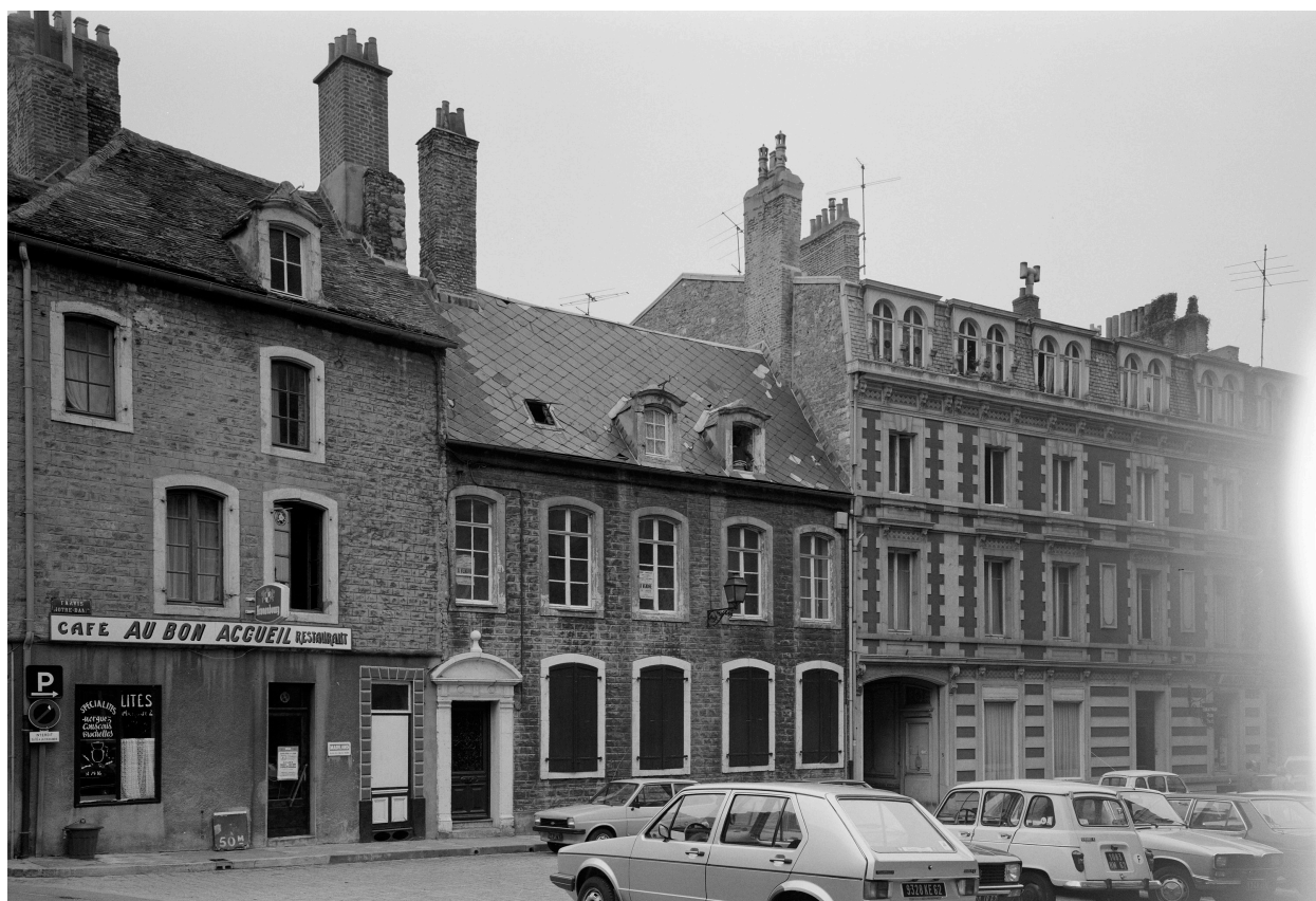
Vue générale sur voie.
