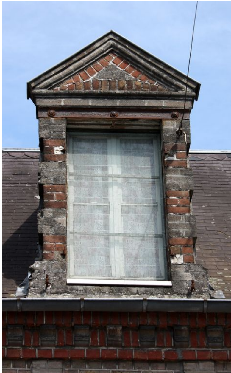
Maison, 24 rue Marius-Sire. Vue de la lucarne.
