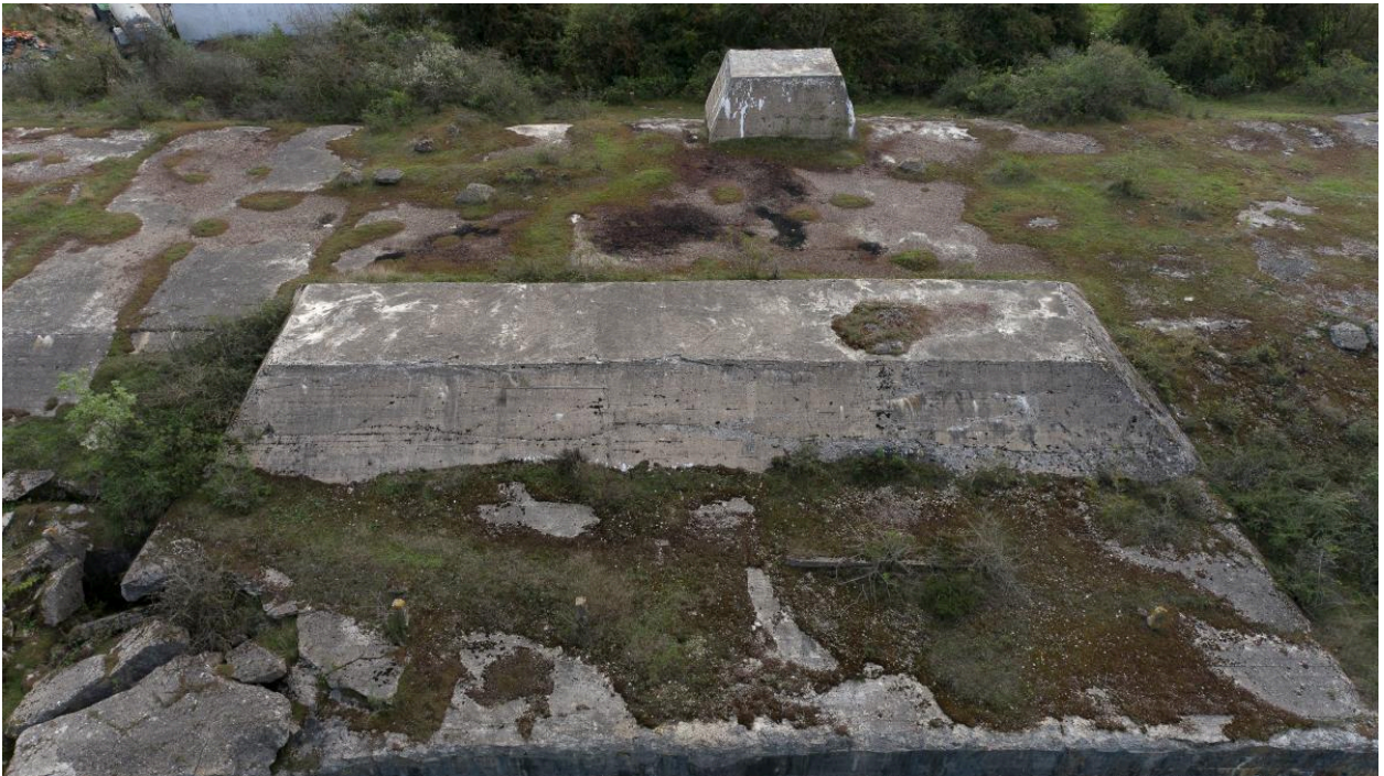
Vue aérienne oblique de l'élévation nord-ouest. Détail de la couverture de sortie de la rampe de catapultage.
