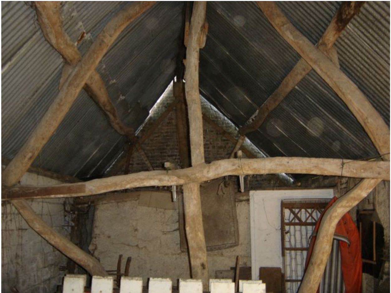
Vue d'une autre ferme de charpente.
