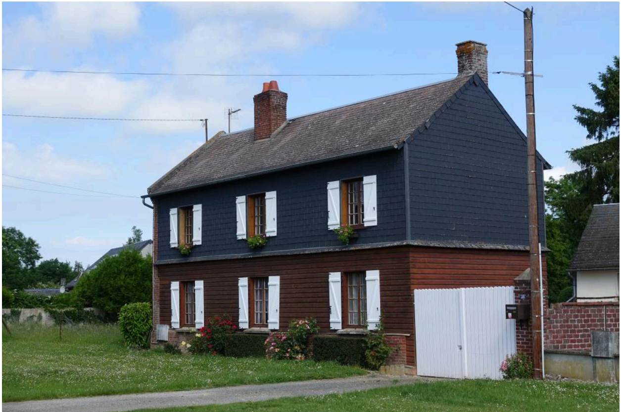
Maison essentée en bois et ardoise au n°20 rue de la Sablonnière, vue du sud-est.
