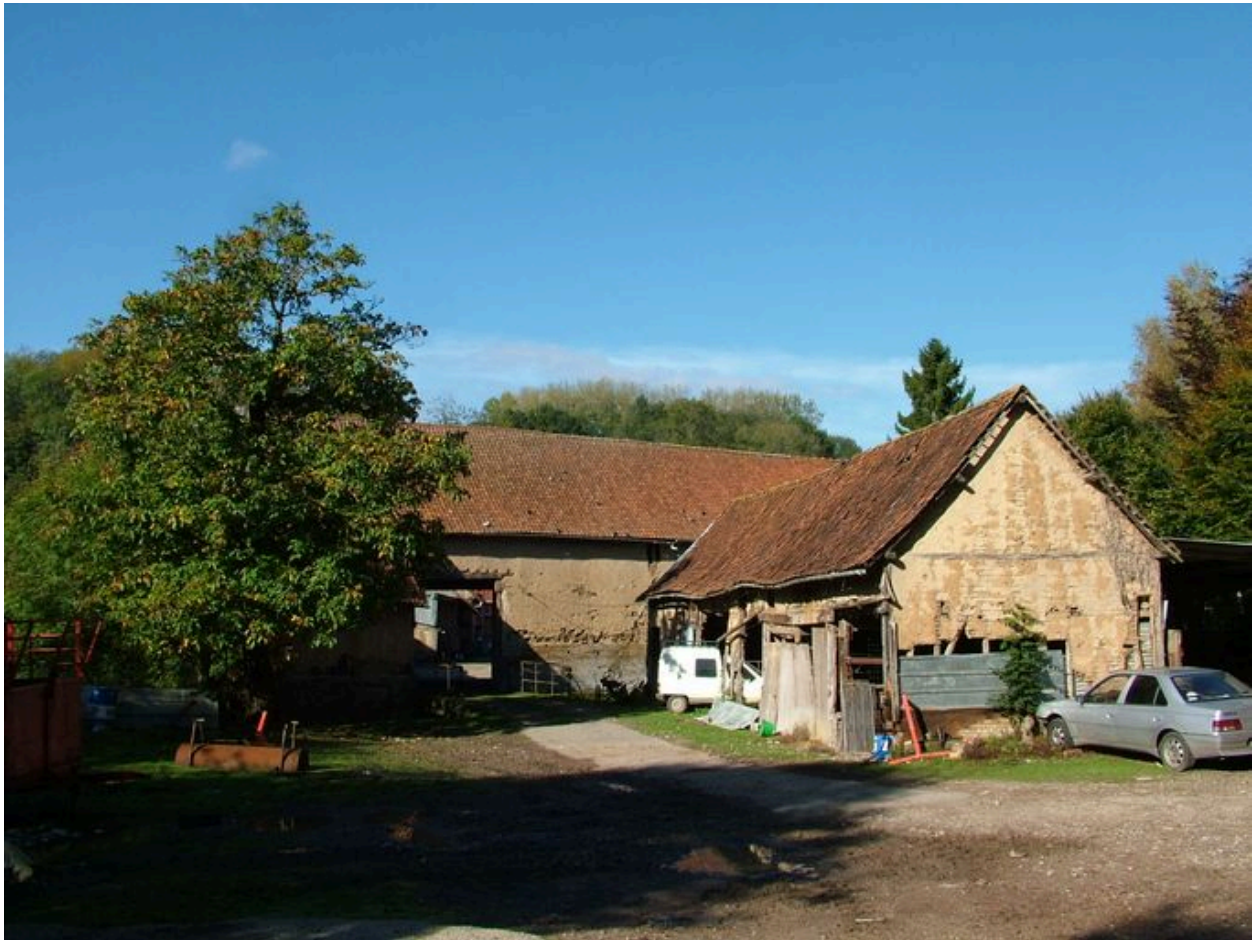
Vue des granges depuis la cour arrière.
