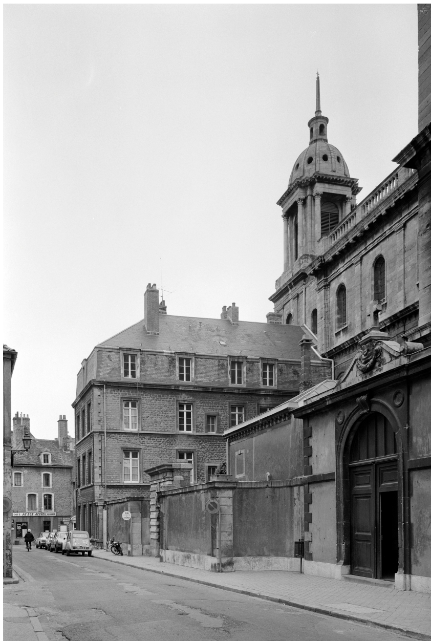
Presbytère, vue d'angle sud-est.
