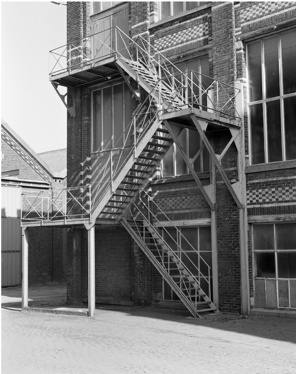
Atelier de fabrication. Escalier de distribution extérieur.
