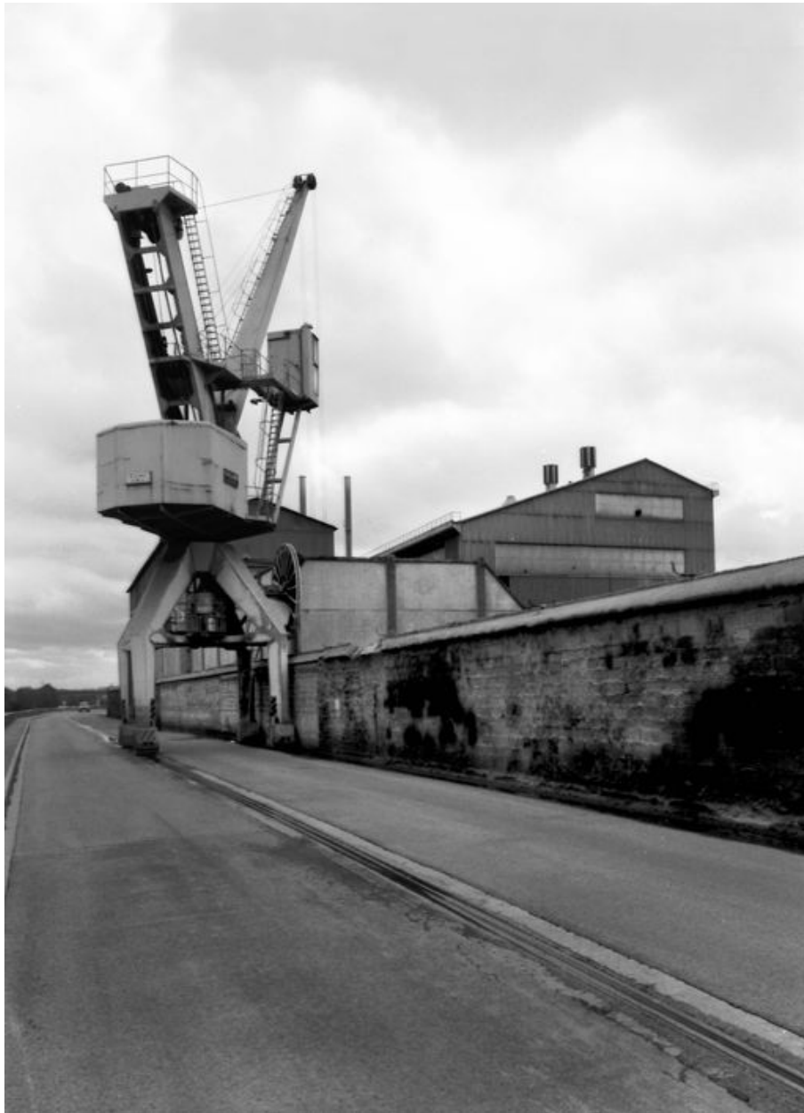
Grue située sur le quai d'Aval.
