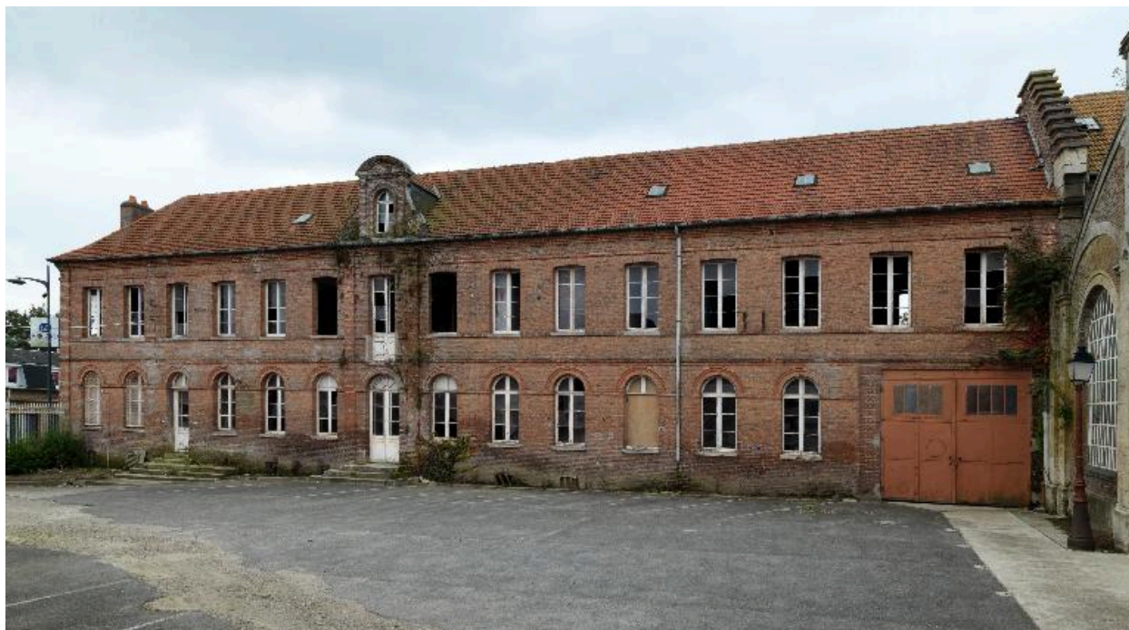
Vue des anciens bureaux et magasins.
