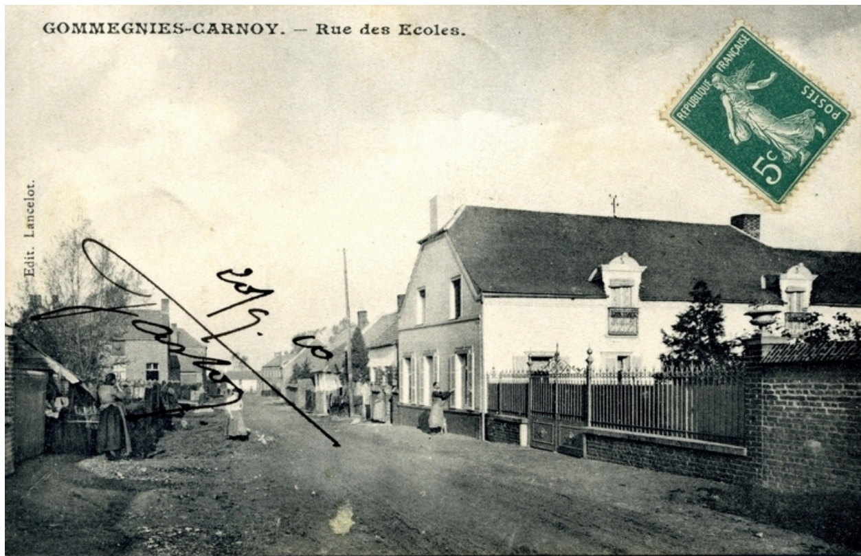
Vue du pignon de la demeure, avant les transformations des années 1890.
