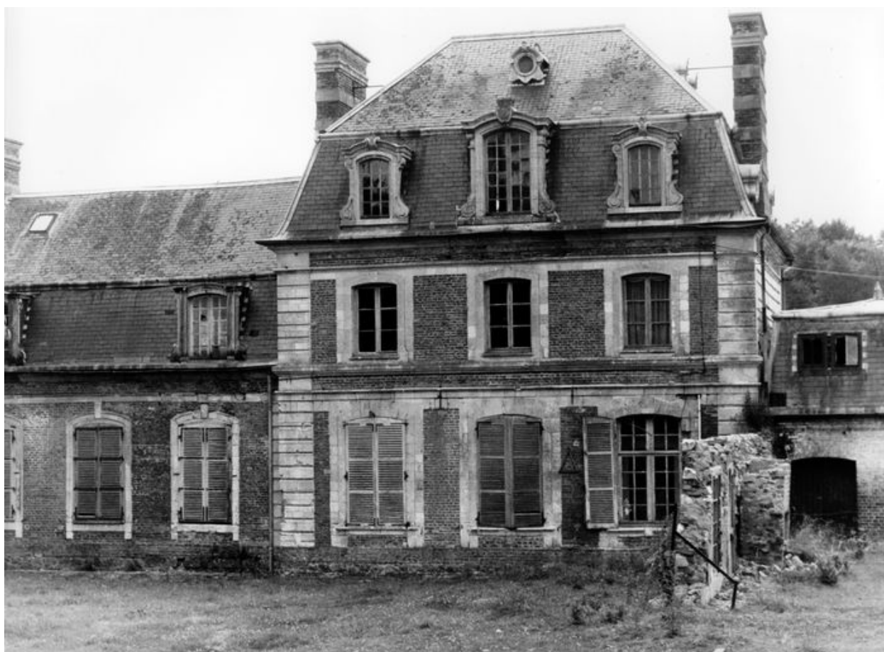
Vue partielle avec le pavillon, 1980 (archives privées).
