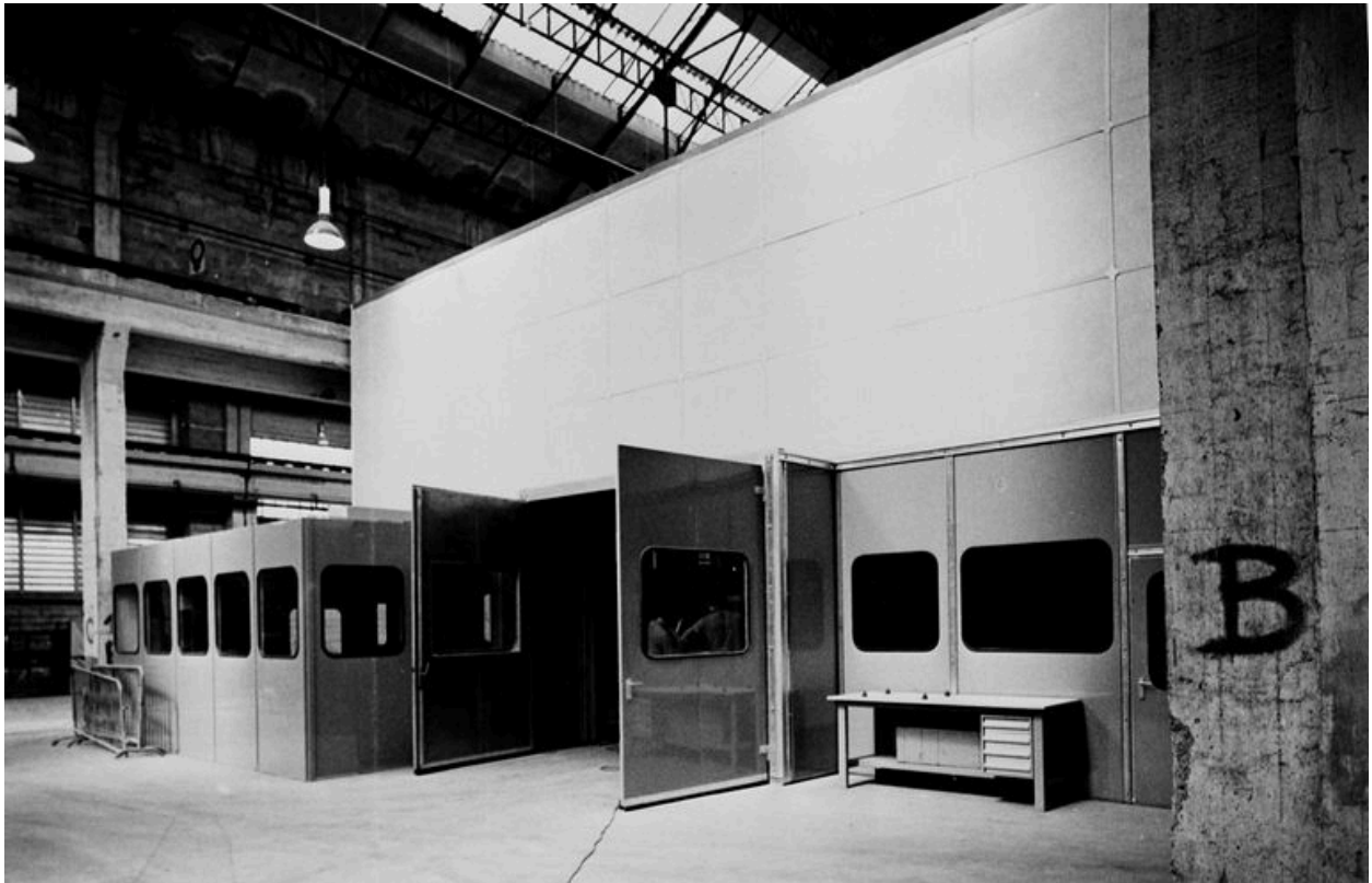
Atelier de fabrication : vue intérieure, vers 1925 (AP).
