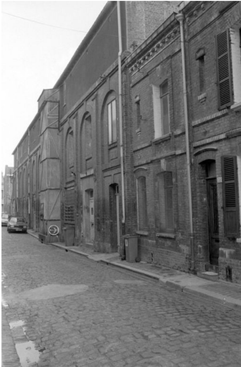
Atelier de la rue Guérard, façade nord.
