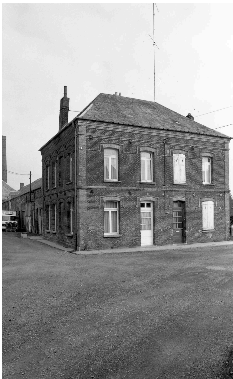
Logement de contremaître existant en 1989, aujourd'hui détruit.
