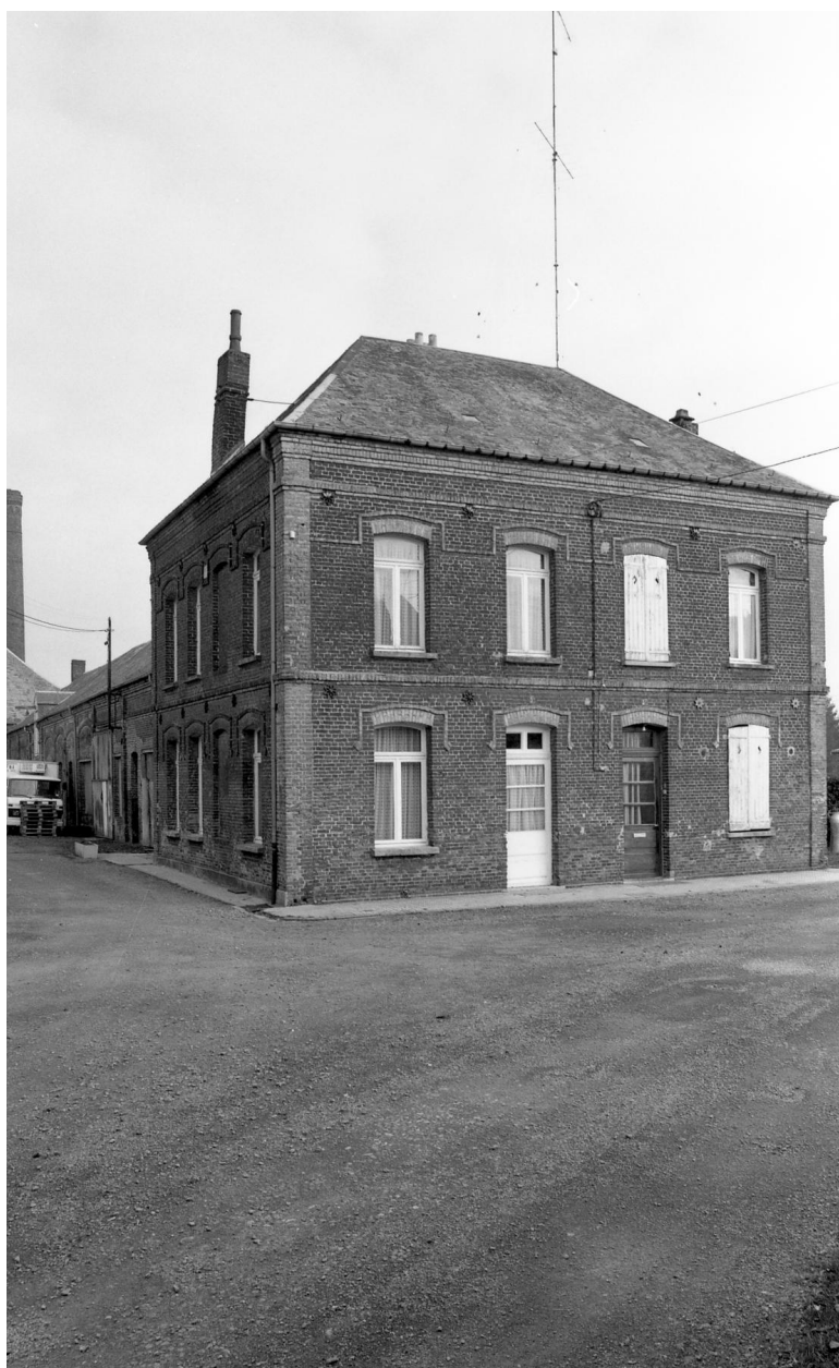
Logement de contremaître existant en 1989, aujourd'hui détruit.
