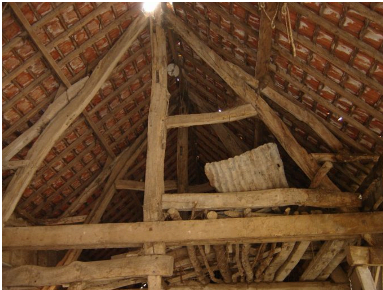
Vue détaillée d'une ferme de la grange.
