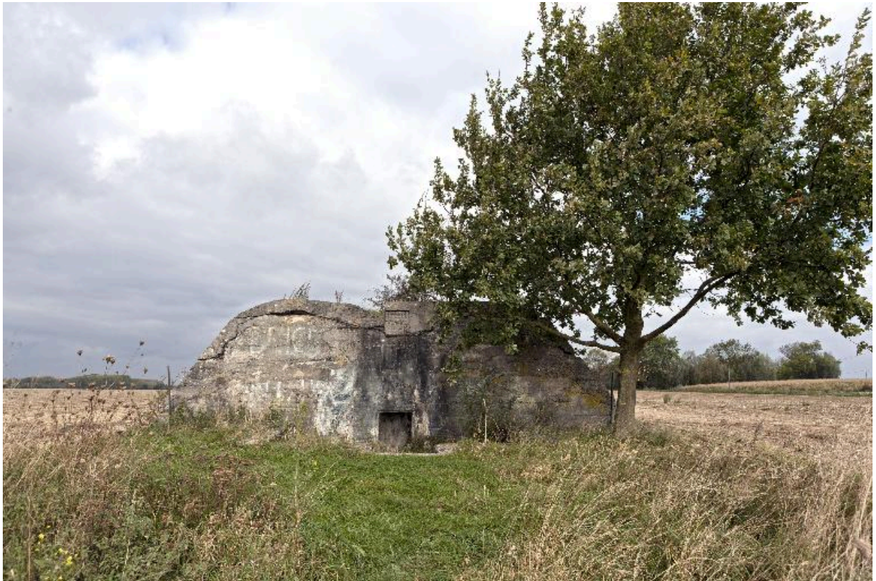
Élévation sud, depuis la R.D. 141
