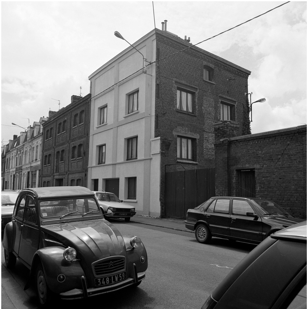
Élévations rue des Prés, vers le Nord. Au premier plan, la touraille, reconvertie en logements, suivie du germoir.
