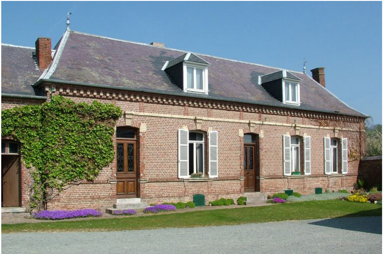
Façade du logis.
