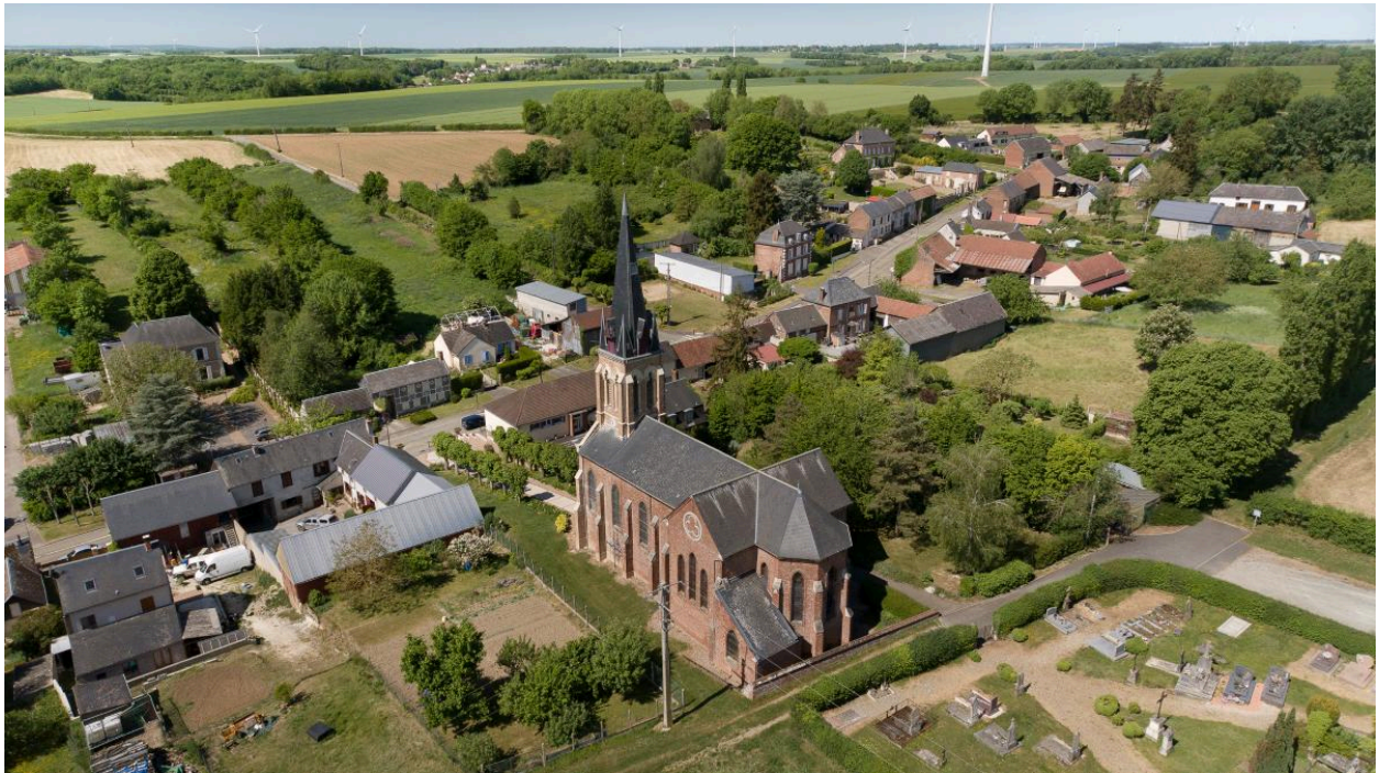
Vue aérienne de l'église depuis le sud-est.
