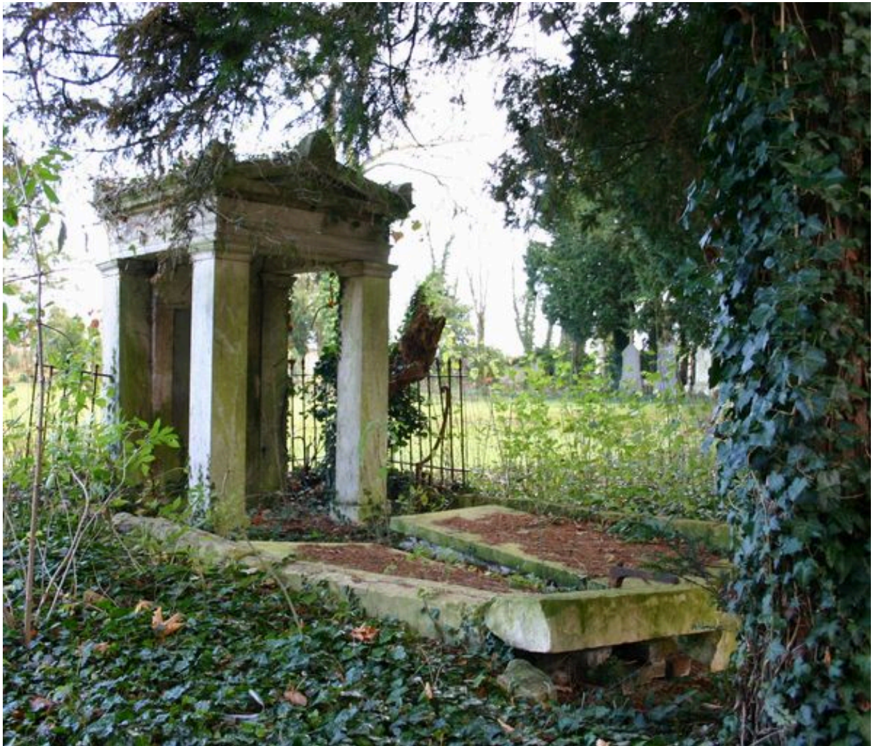
Vue générale, depuis le côté.
