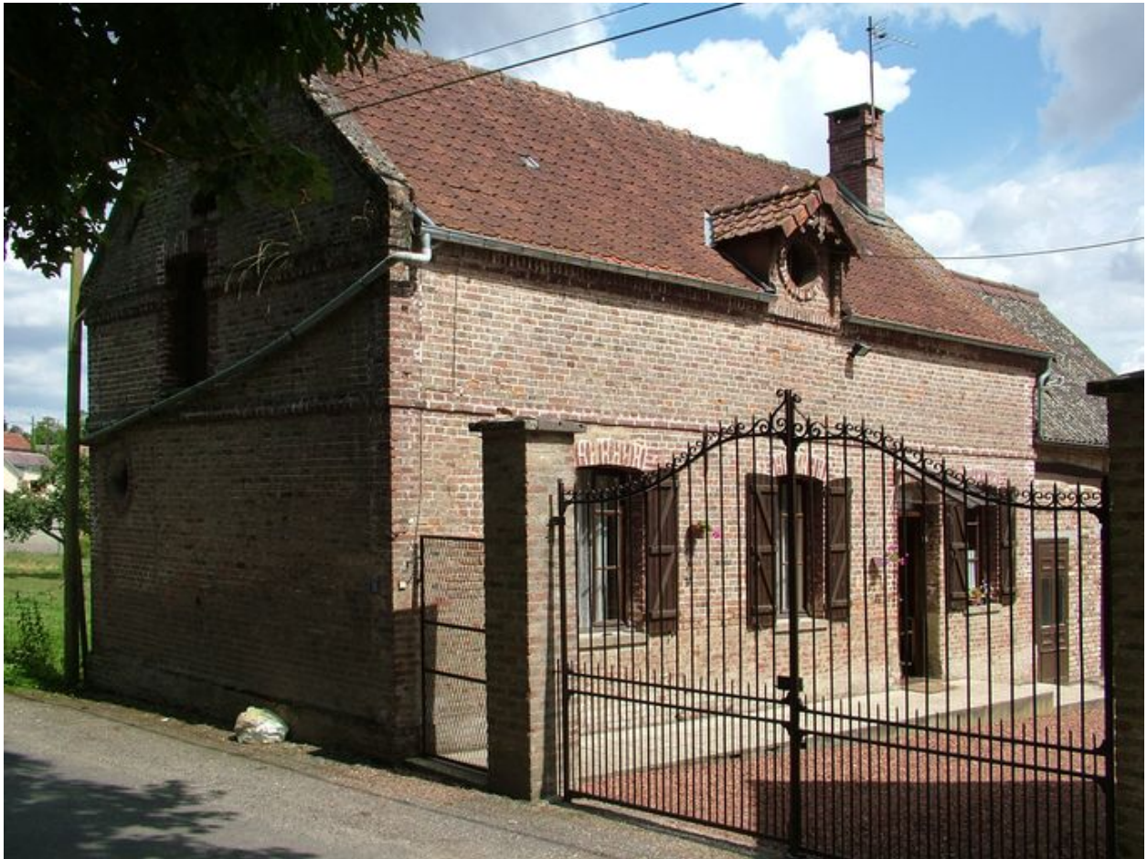
Bouchon, logis de la ferme, 10 rue de L'Etoile, limite 19e siècle 20e siècle.
