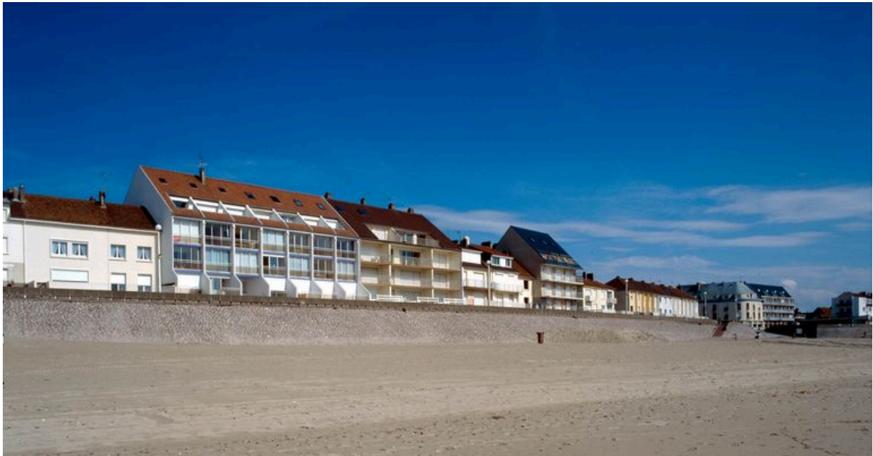
Le front de mer de Fort-Mahon-Plage : vue d'ensemble de la digue nord, depuis le nord.
