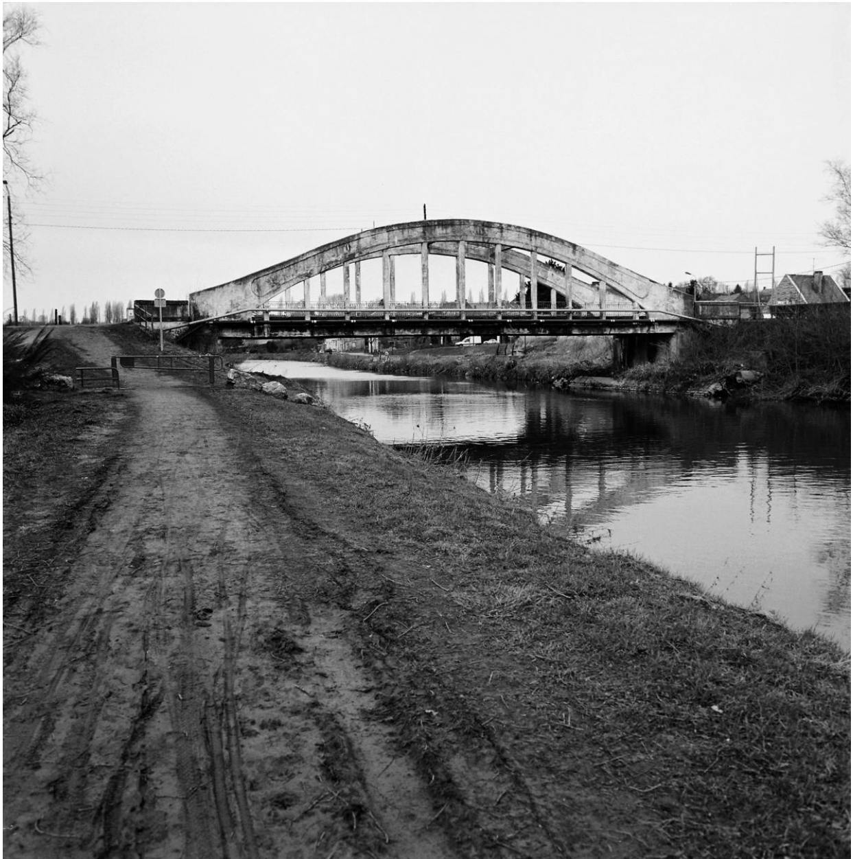
Vue générale du pont en béton reliant Assevent à Rousies.
