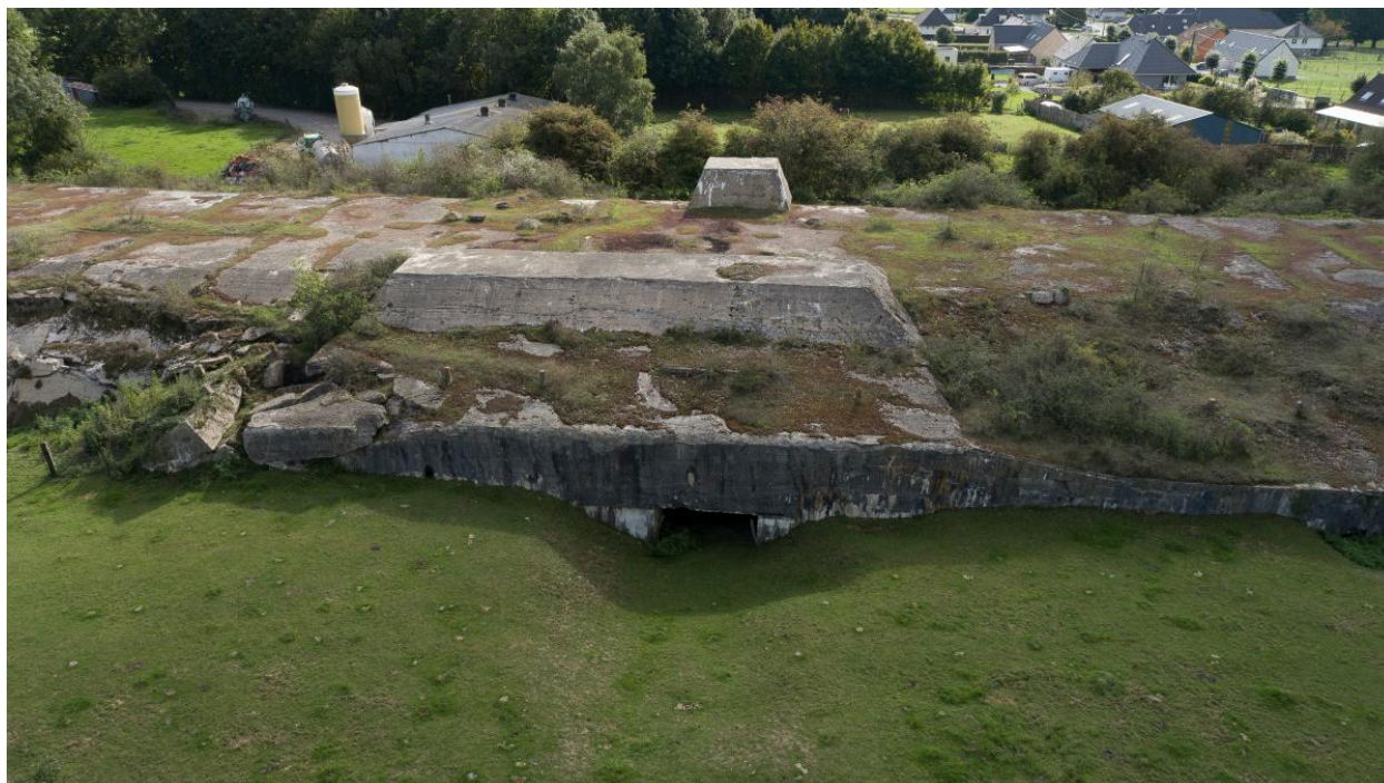
Vue aérienne de la partie centrale, vers le sud-est. Sortie de la catapulte de lancement.
