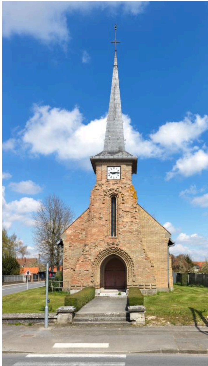
Vue de la façade principale, depuis le sud.
