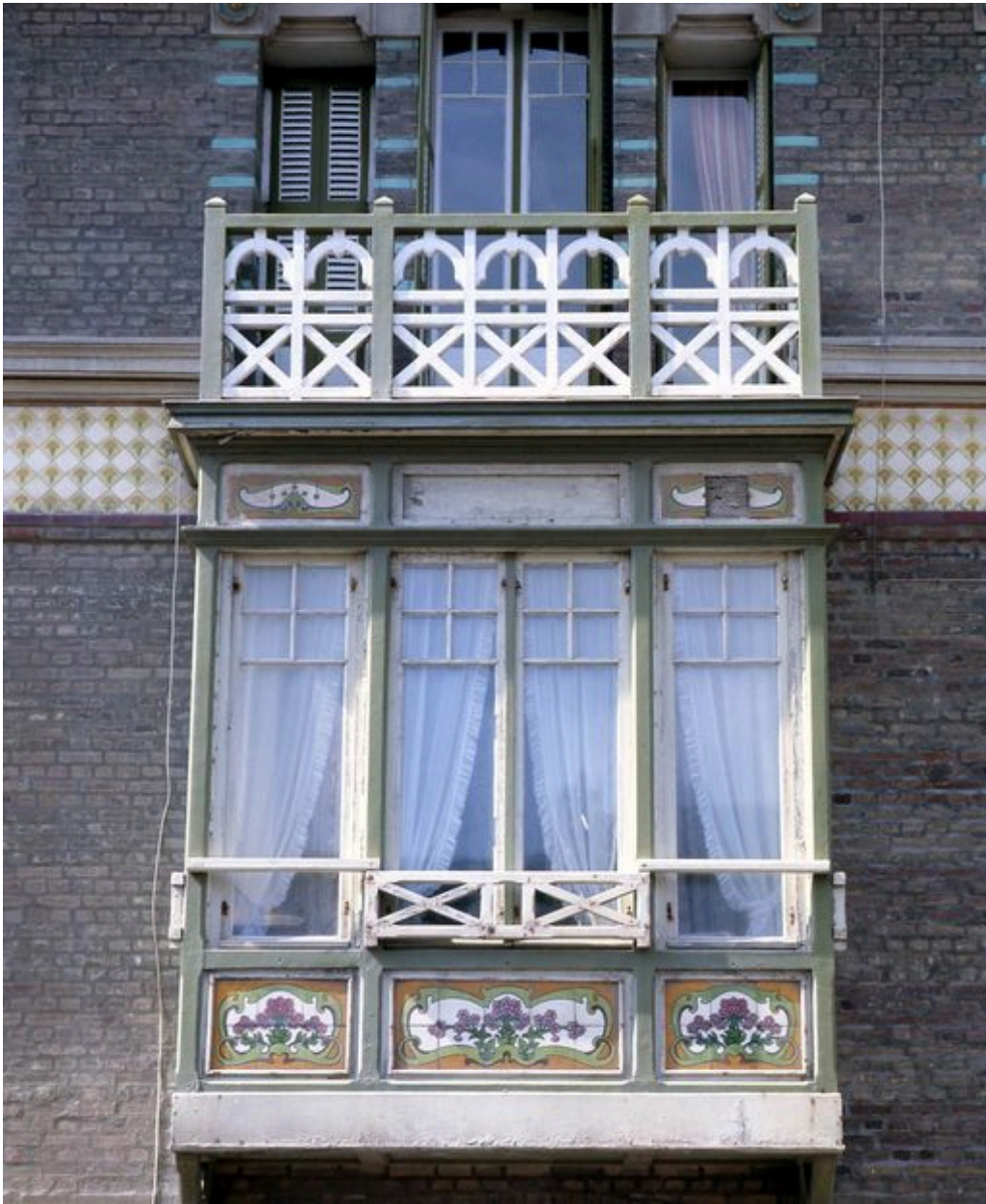
Détail d'un bow-window de l'étage carré.
