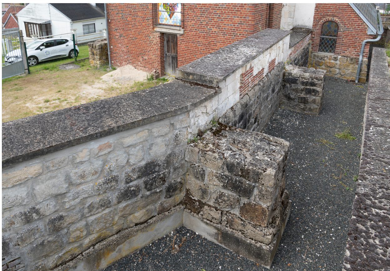
Emprise de l'ancien chevet avec les bases des contreforts.
