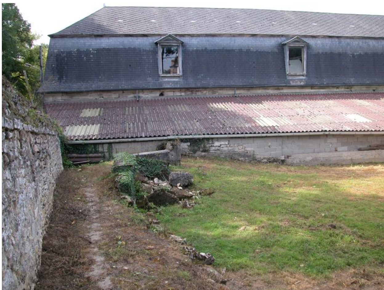
Façade postérieure de l'atelier de filature et vestiges du canal d'amenée comblé.
