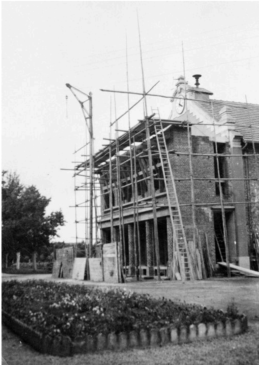
Extension de l'usine (AP).
