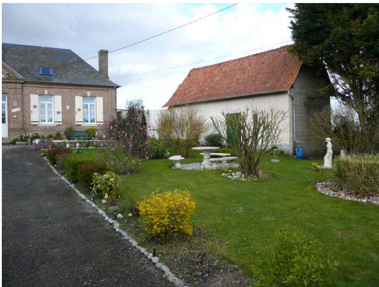
Vue de la grange.
