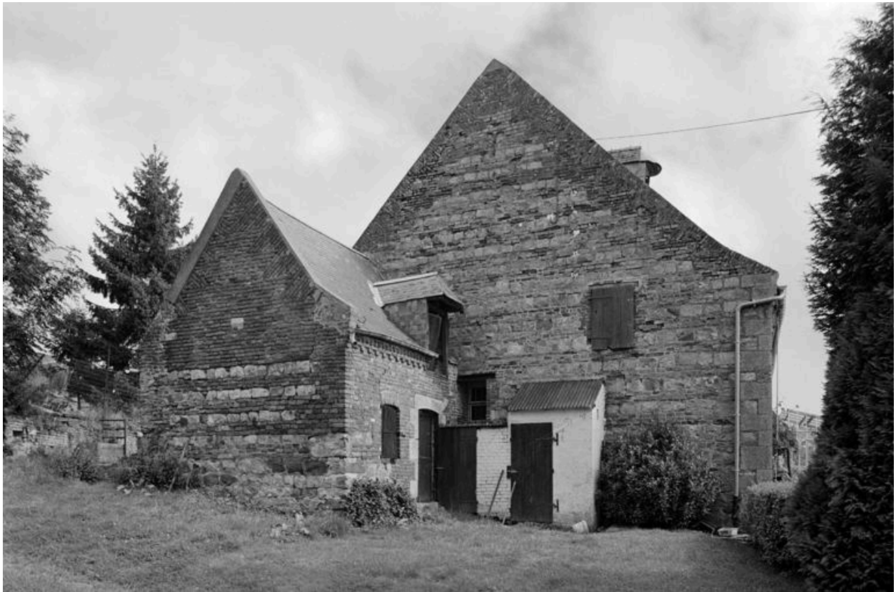
Vue du pignon du logis (daté de 1804).
