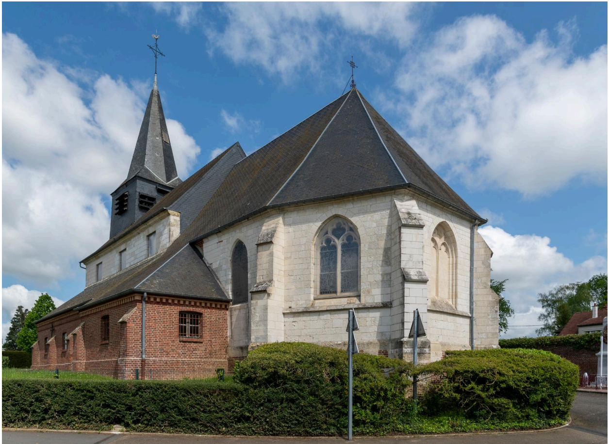
Vue générale depuis le sud-ouest.
