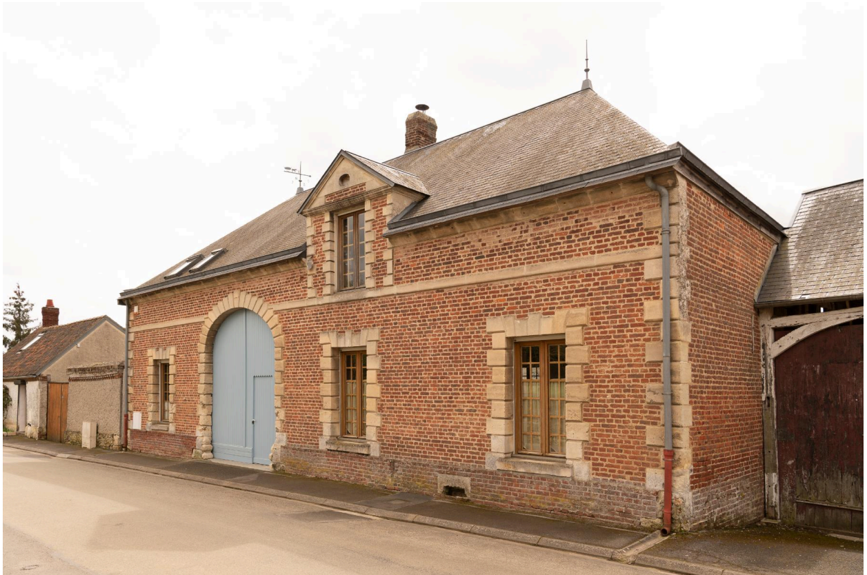
Ancienne boulangerie, n°467 de la rue Bulnoise, vue prise depuis le nord-ouest.
