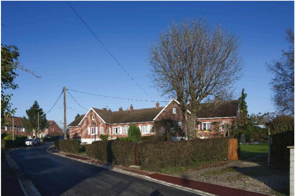
Vue des logements à deux unités d'habitation.
