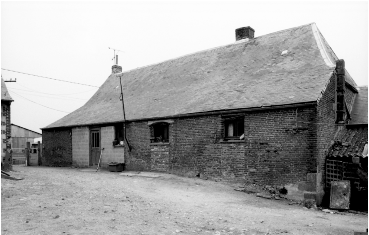
Elévation arrière du logis.
