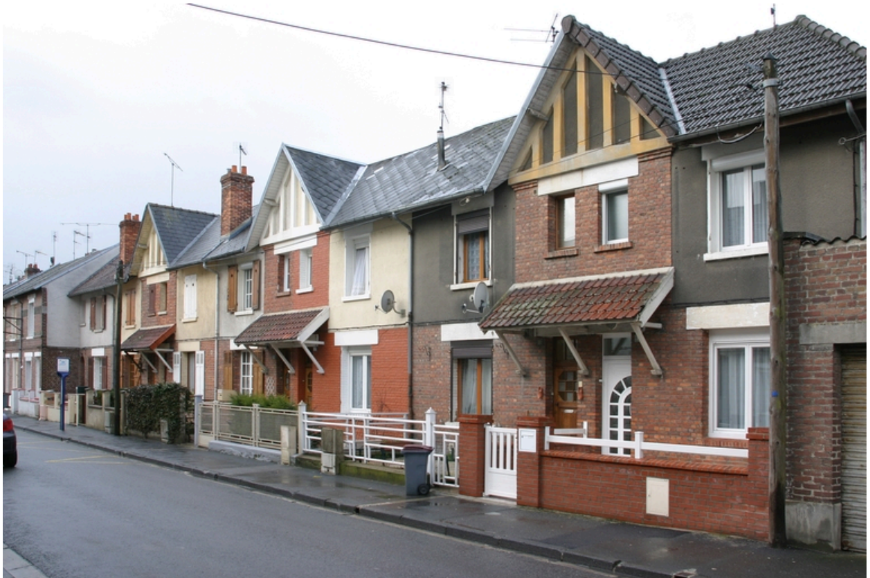
Logements de type B, chemin Clastrois.
