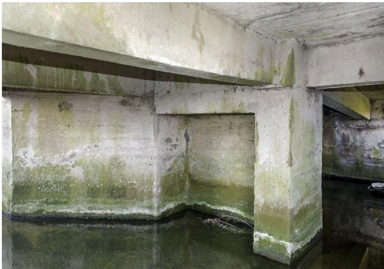
Vue intérieure de la chambre de tir, vers la soute à munitions
