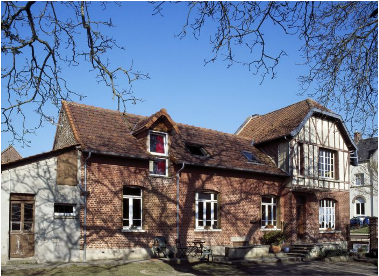
Vue générale depuis la cour.
