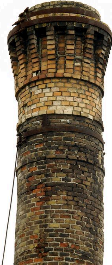
Détail du couronnement d'une des trois cheminées.
